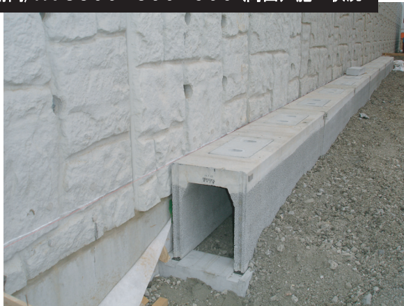
小右衛門/NVS300×300～500 (両面) 施工状況
