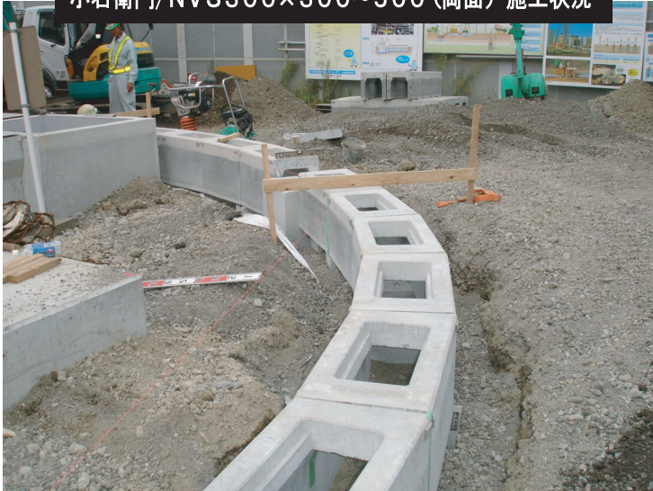
小右衛門/NVS300×300～500 (両面) 施工状況
