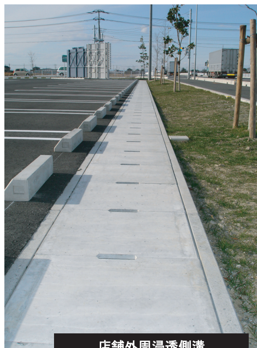
店舗外周浸透側溝
