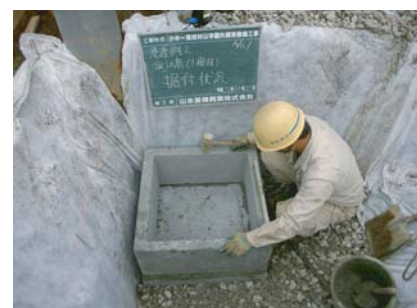
浸透樹 KM施工状況
