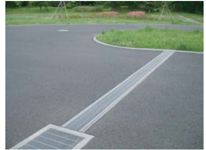
浸透側溝FU180施工
