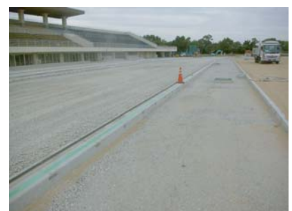
SKドレーン施工状況
