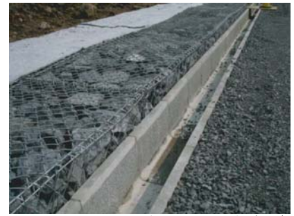
一級河川 田川 堤防工事
