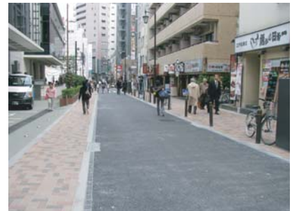
東京都港区芝5丁目 道路整備工事
