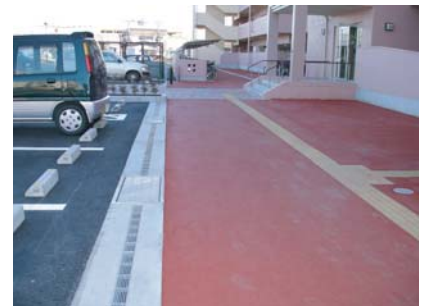
県営住宅 浸透円形側溝
