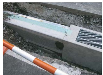
港区芝5丁目 浸透円形施工写真
