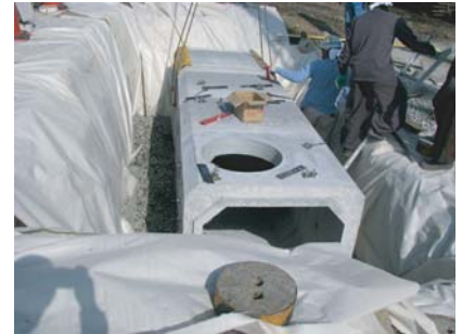
大田区 浸透BOX点検孔掘付
