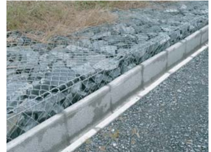
浸透側溝 FU 施工
