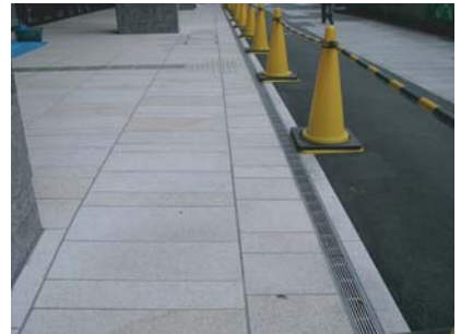
都市型円形側溝 施工状況
