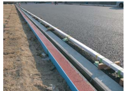
SKカービング布設状況
