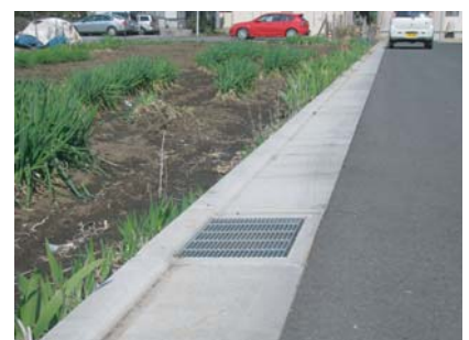
L型側溝用浸透樹(LK樹)
