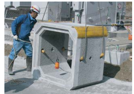
浸透BOX1000 施工状況
