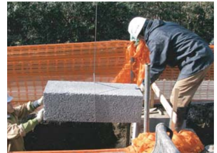
浸透トレンチ KT1-200(W=400)施工状況
