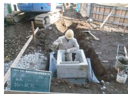
縁塊一体型JKC施工状況
