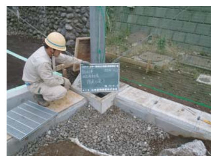
東京都武蔵野村山 村山学園小中一貫外構工事
