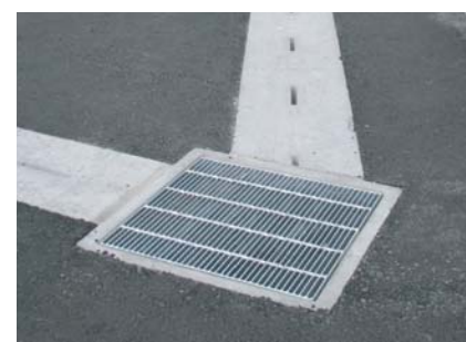
浸透角柵JKC 施工状況
