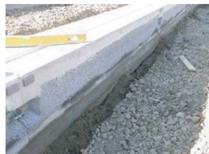
SKDドレーン(両面透水)施工
