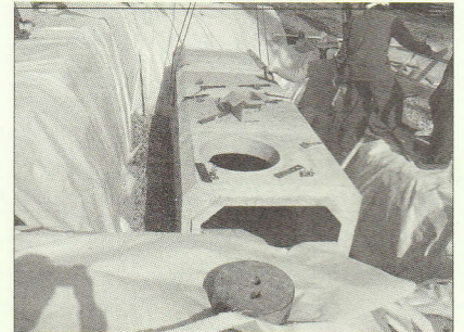
大田区 浸透BOX点検孔据付
