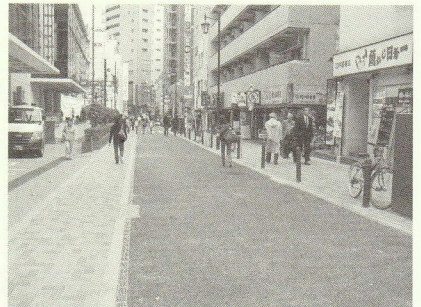
東京都港区芝5丁目 道路整備工事
