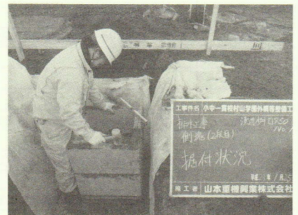
浸透枳 据付状況
