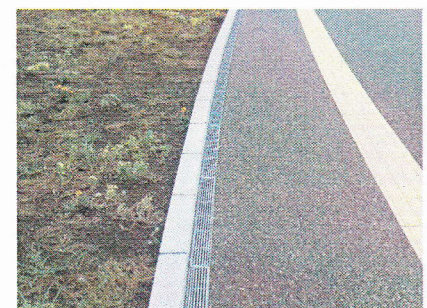
松山下公園施工写真 ③
