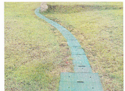
松山下公園施工写真 ①
