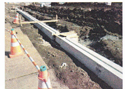
青山学院グランド施工写真 ③
