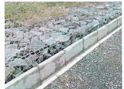
宇都宮市 一級河川田川堤防強化工事
