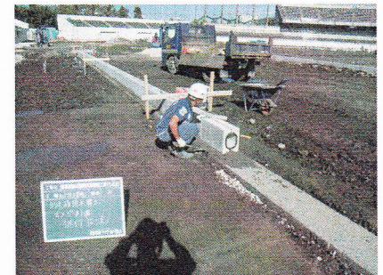
埼玉県 駒場運動公園競技場施工写真 ①
