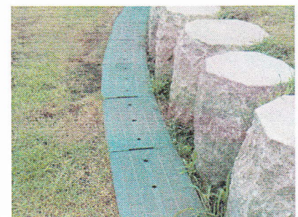
松山下公園施工写真 ②
