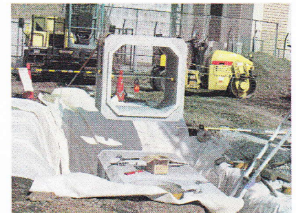
浸透BOX施工写真 ③
