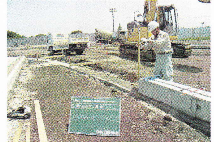
東京都 武蔵野の森スポーツ施設 布設状況
