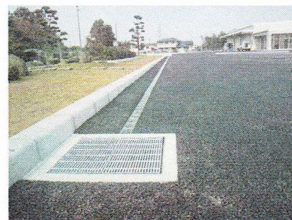
茨城県 筑西市JA筑西 施工状況
