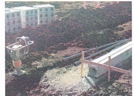
青山学院グランド施工写真 ①
