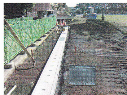
東京都 清瀬運動場芝生化工事 施工状況
