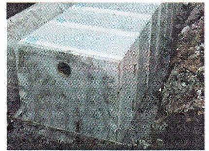
浸透BOX施工写真 ①
