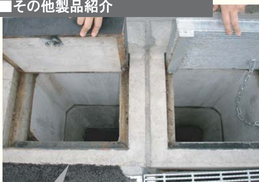
「①ルーチンガ蓋・鉄製製の閉鎖状態 右:流入側 左:オーバーフロー側」
