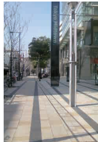
東京ミッドタウンプロジェクト （FU300D 全面透水）
