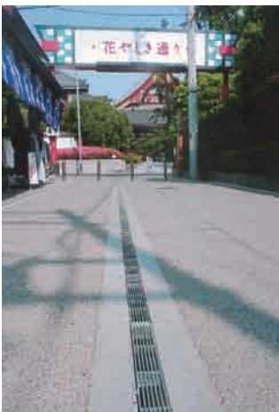
花やしき通り改良工事 （円形側溝φ200 フラット）
