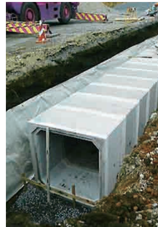
某ディーラー 浸透 BOX 布設 （浸透 BOX1500）
