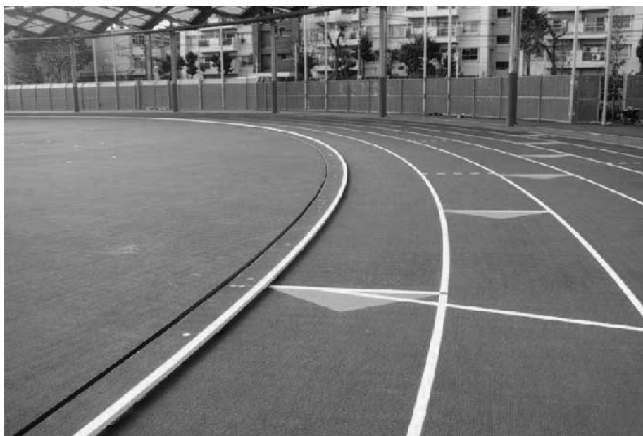
文部科学省発注 ナショナルトレーニングセンター (屋外トレーニング施設)
