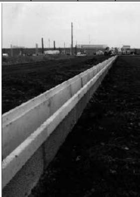
浦和レッズサッカー練習場 施工現場
