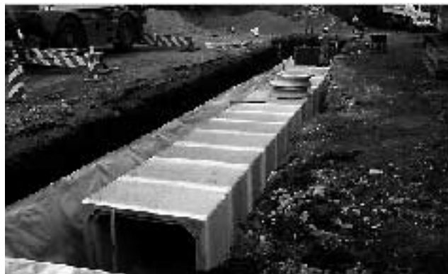
埼玉県日高市日産ディーゼル雨水排水工事
