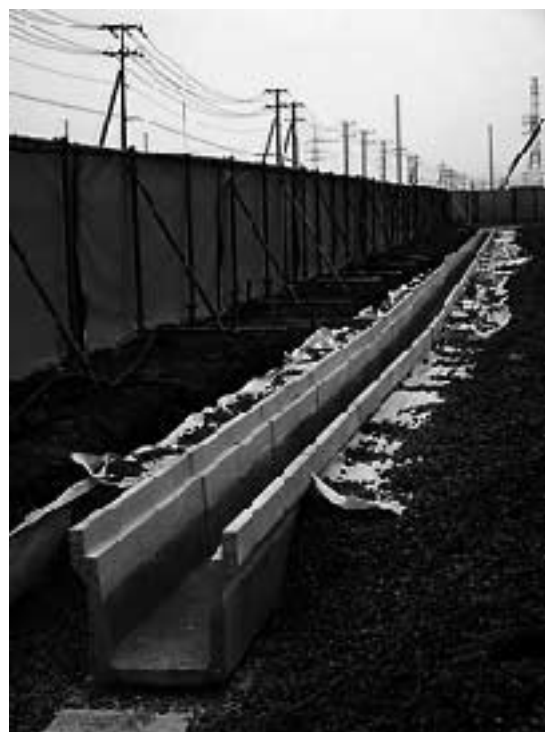
埼玉県菖蒲町「モラージュ菖蒲」 KSU500A（全面透水）施工状況
