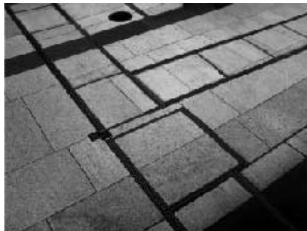
浸透側溝FU化粧蓋仕様 (東京都港区六本木ミッドタウンにて)
