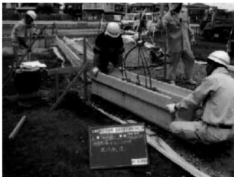
茨城県古河市位置指定道路 KSU300A（全面透水）施工状況
