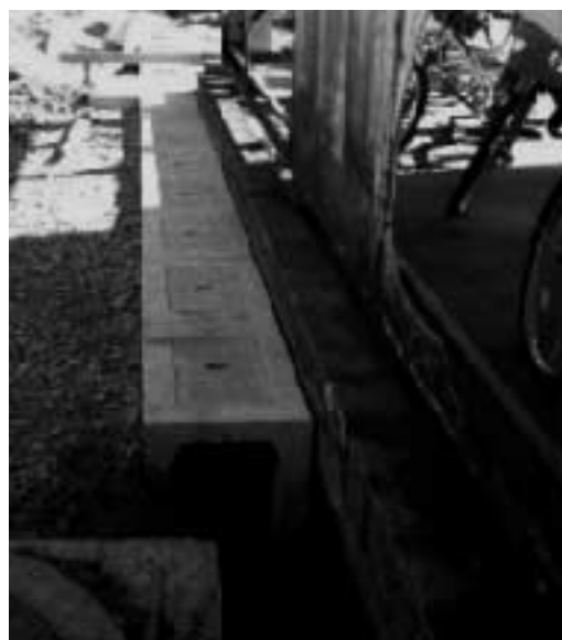
栃木県宮城内南住宅工事 NFU-P II 施工状況
