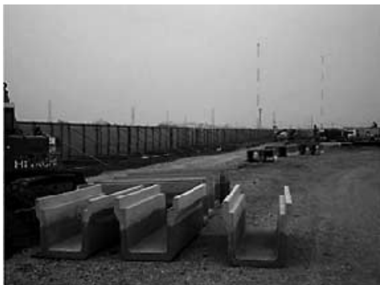
埼玉県菖蒲町「モラージュ菖蒲」 KSU500A（全面透水）施工状況
