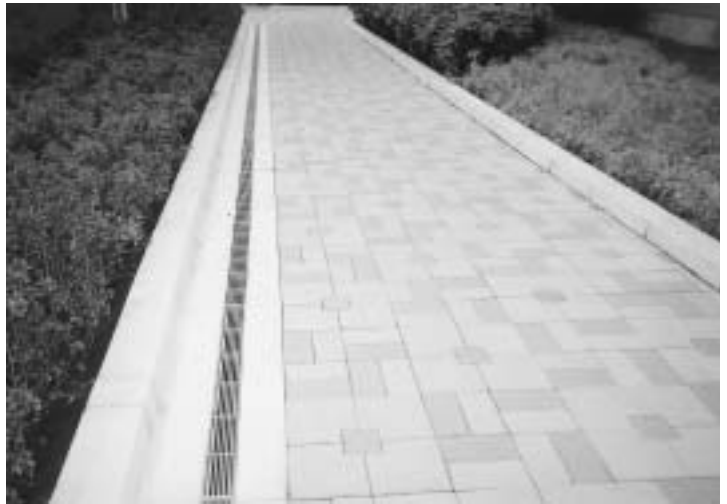
栃木県営春日住宅外構工事
