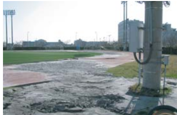
某M大学グラウンド液状化 千葉県浦安市
