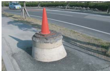
マンホールの浮き上がり現象 千葉県浦安市
