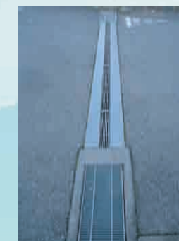
車両乗り入れ横断部
