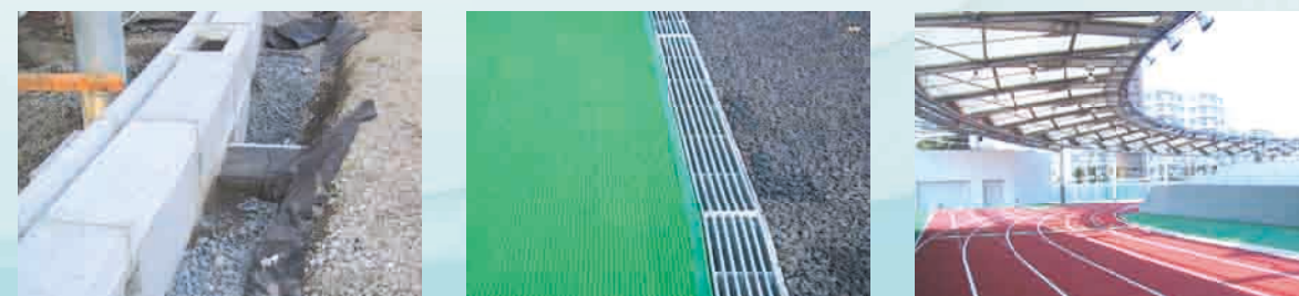
東京都北区 ナショナルトレーニングセンター施工写真
