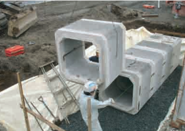
浸透BOX施工状況
