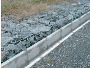
田川堤防強化工事
