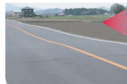
液状化による地面の波うち・ひび割れ
