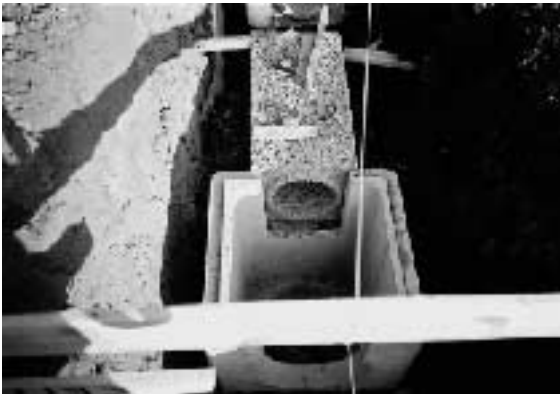
◀ 神奈川県藤沢市内 KT1-200施工現場
