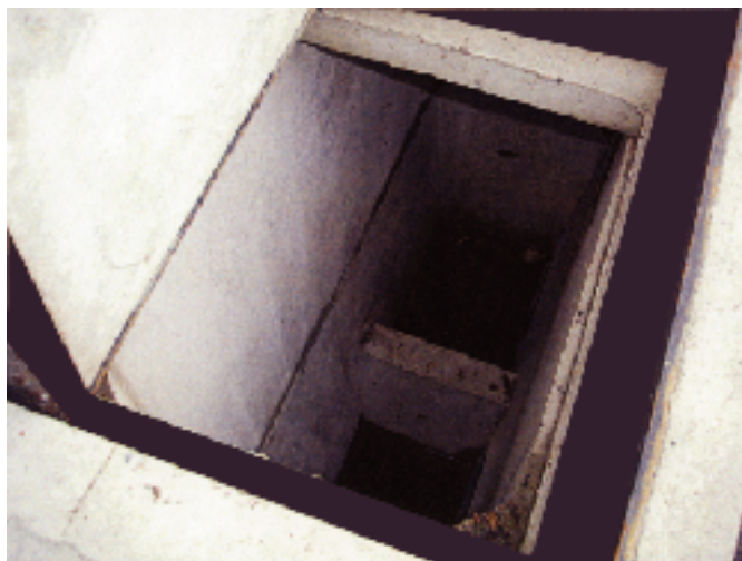
② 雨水2連枡内部写真 中心の柱の壁により、2つに分かれます。
