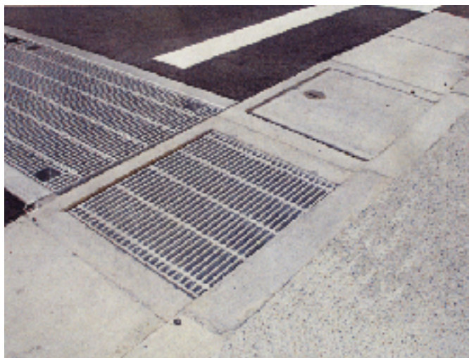
④ 施工写真－2 横断側溝からも流入し既存の本管へ流入、 大雨時、枡がオーバーフローした場合新設へ流入。
