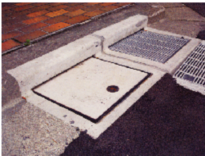
③ 施工写真－1 L型側溝に合わせて施工されます。
